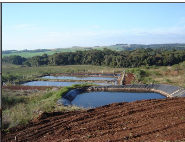
FOTO 06 – Tratamento de Efluente
